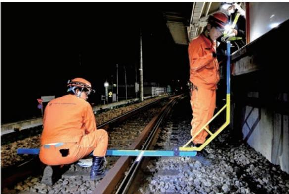
写真-2 建築限界定規を使用した手計測
